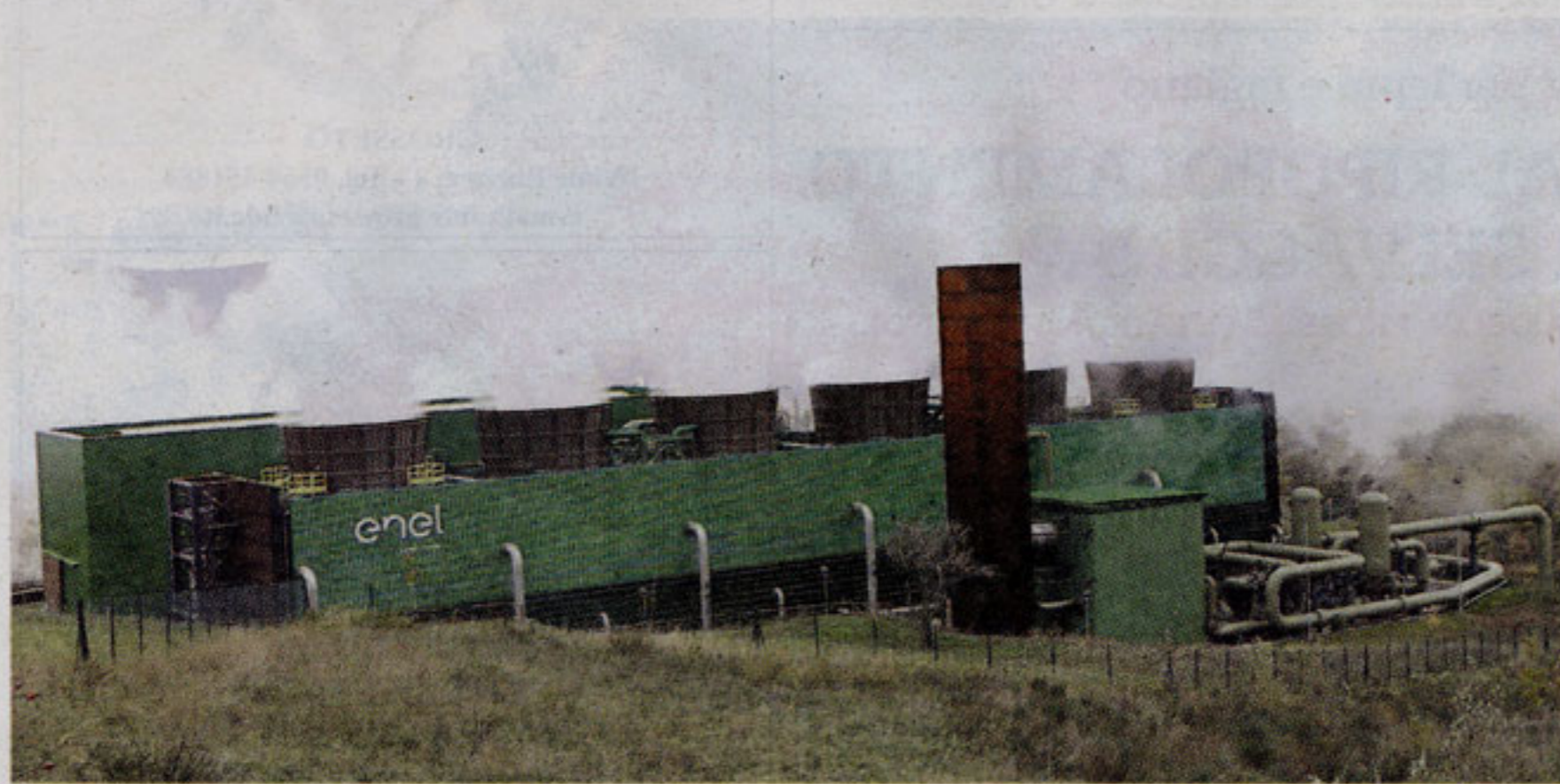
La centrale geotermica di Bagnore
