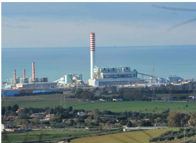
La centrale di Tvno
